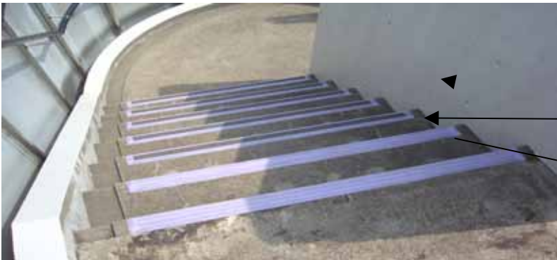
モルタル表面強化剤 (MC2513) 施工前
