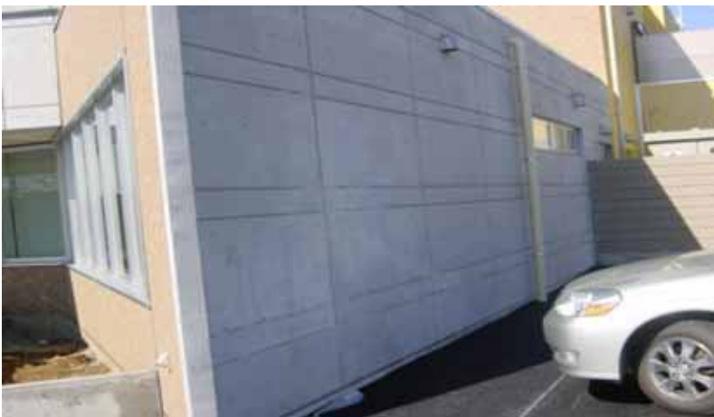
モルタル表面強化剤 (MC2513) 施工前
