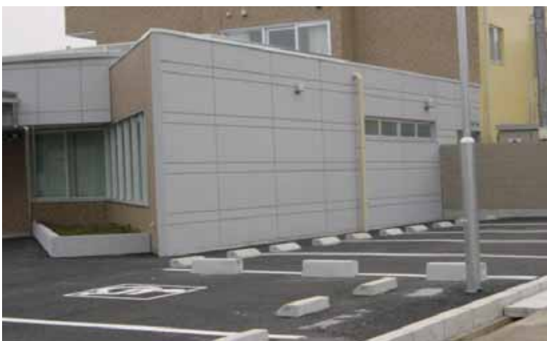
モルタル表面強化剤 (MC2513) 施工後
