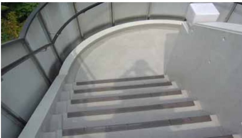
モルタル表面強化剤 (MC2513) 施工後
