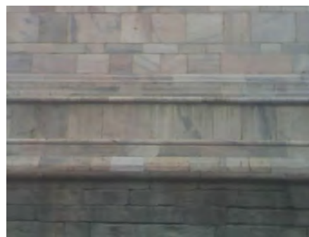
大理石洗浄後施工
