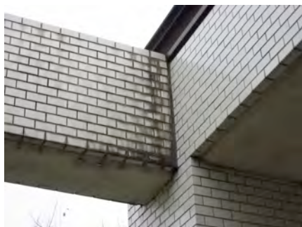
前清掃及び施工 以前
