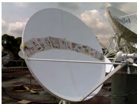
洗浄後、施工箇所を区分
