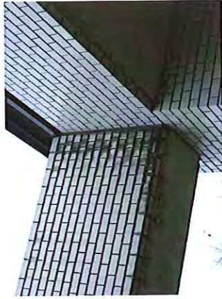
前清掃及び施工 以前
